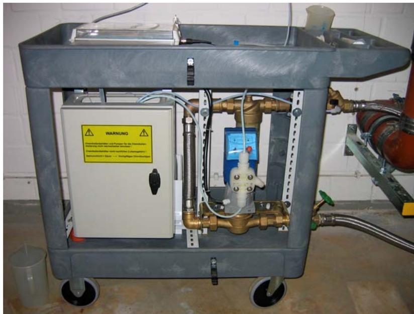
Betriebssichere drucklose automatische Erzeugung einer Chlordioxidlösung mit 2 g/l.
